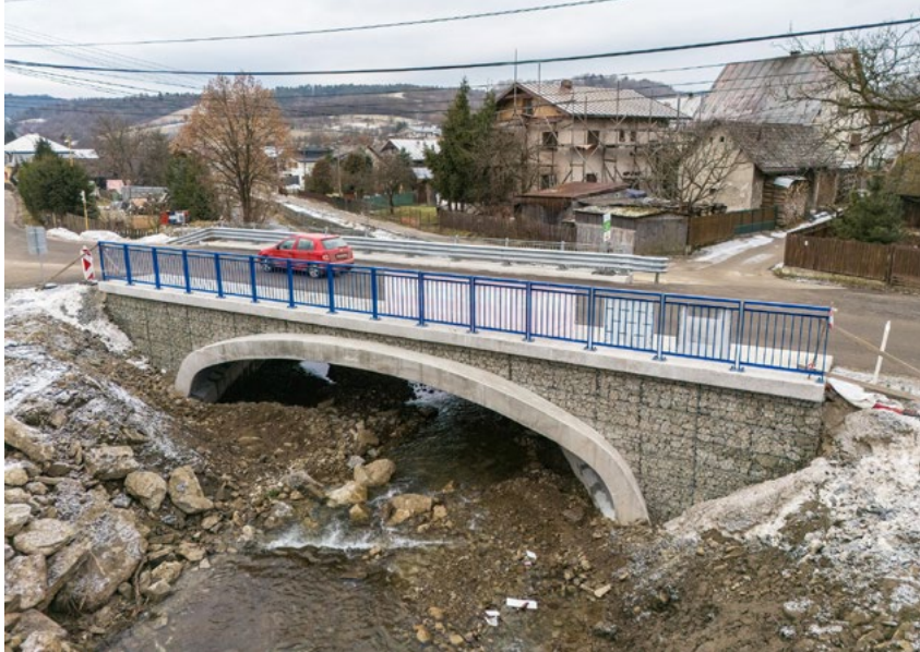
Most bol postavený technológiou využívanou aj pri diaľničných mostoch. Foto: František Dokoupil
