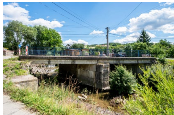
Pôvodný most pred zbúraním. Foto: archív SC ŽSK
