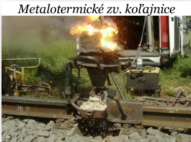
Metalotermické zv. koľajníc
